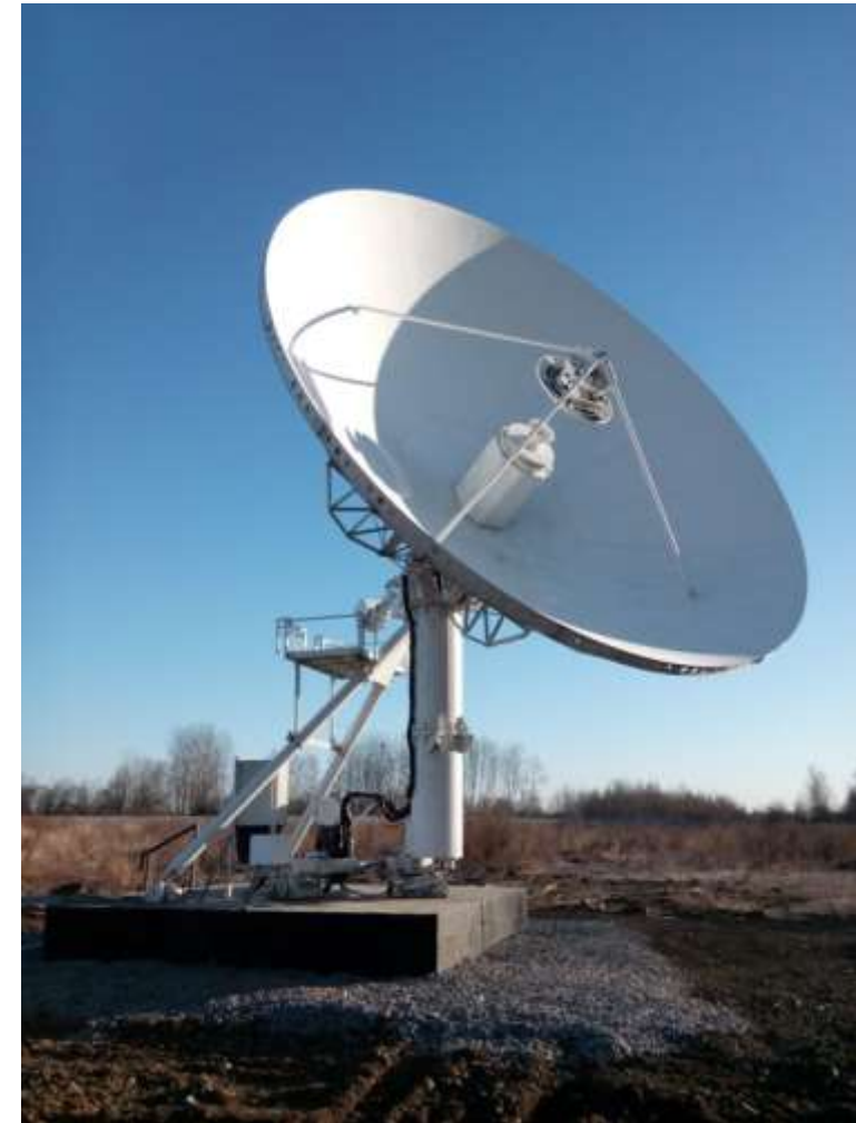
Станция радиоконтроля (г.Хабаровск)
